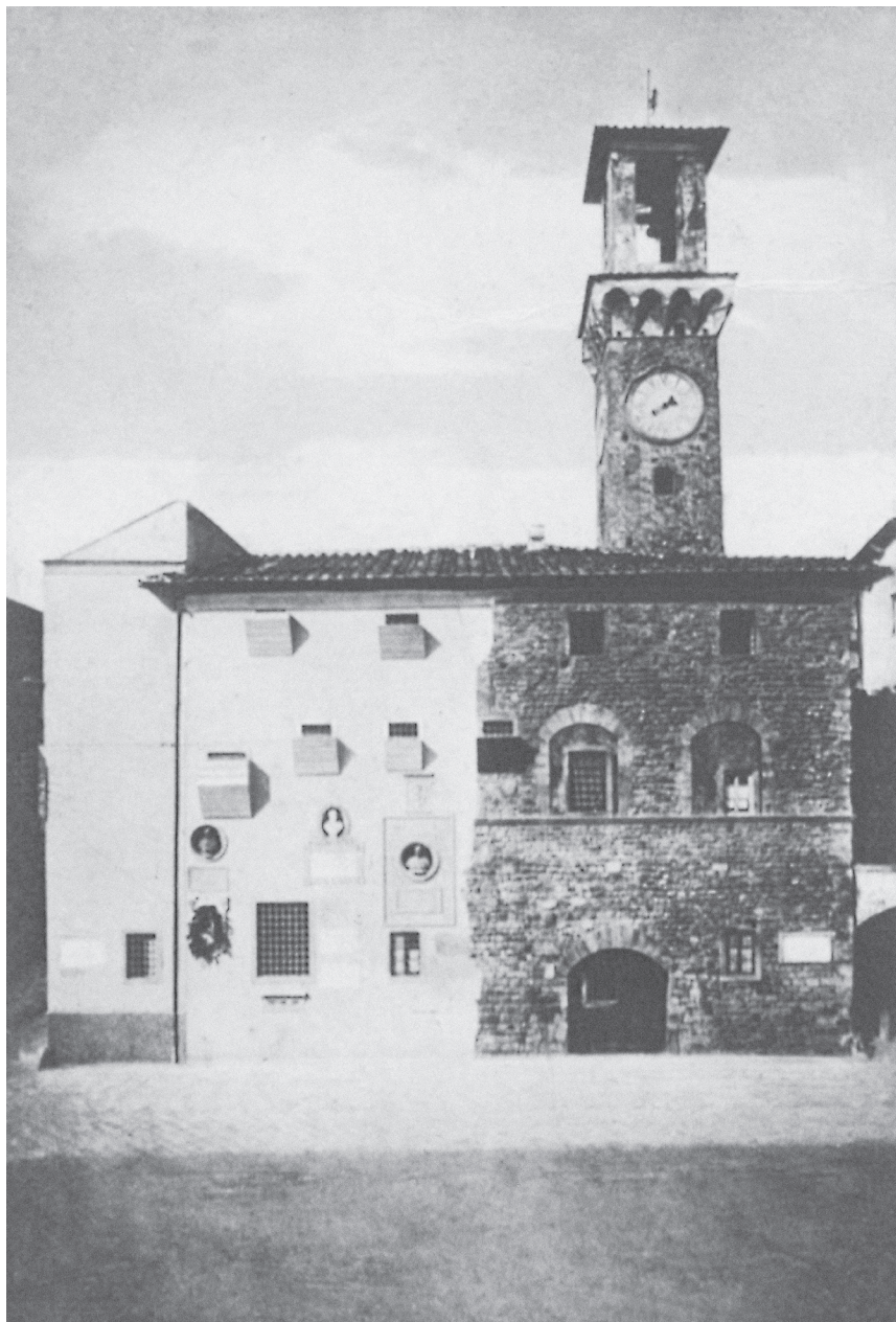
4. Il palazzo Pretorio dopo i lavori di parziale rimozione dell'intonaco dalla facciata principale, deliberati dal Consiglio comunale nel 1913 e ultimati nei primi mesi del 1924. (Collezione Adelmo Brogi).
