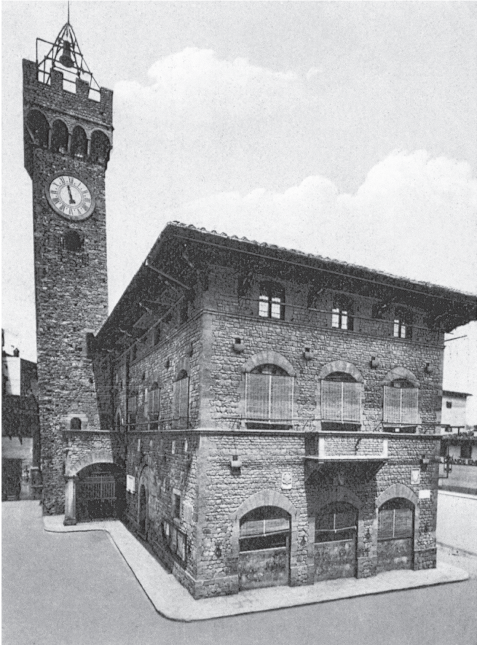
6. Il palazzo Pretorio dopo il recupero diretto dall'architetto Ezio Cerpi e concluso nel 1927. (Collezione Adelmo Brogi).
