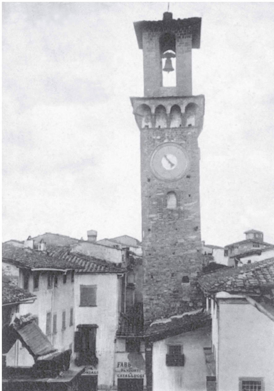
5. La torre del palazzo Pretorio prima dell'intervento di sostituzione della cella campanaria con una cuspid e ferro, predisposto dall'ingegnere Tullio Torsellini nel 1927. (Collezione Adelmo Brogi).
