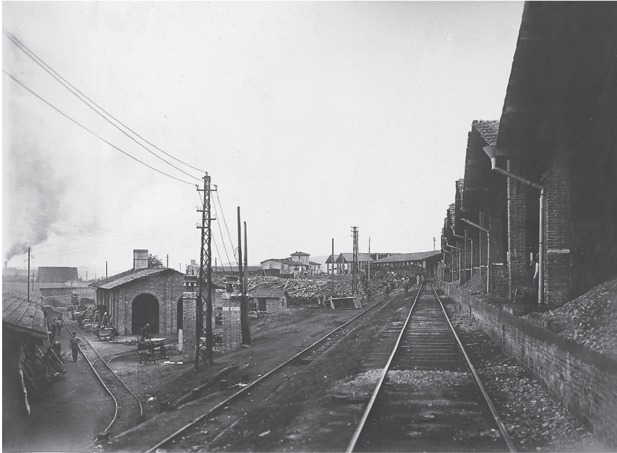
Capannoni di deposito.
