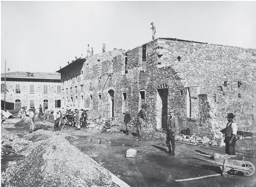
Case operaie in costruzione.
