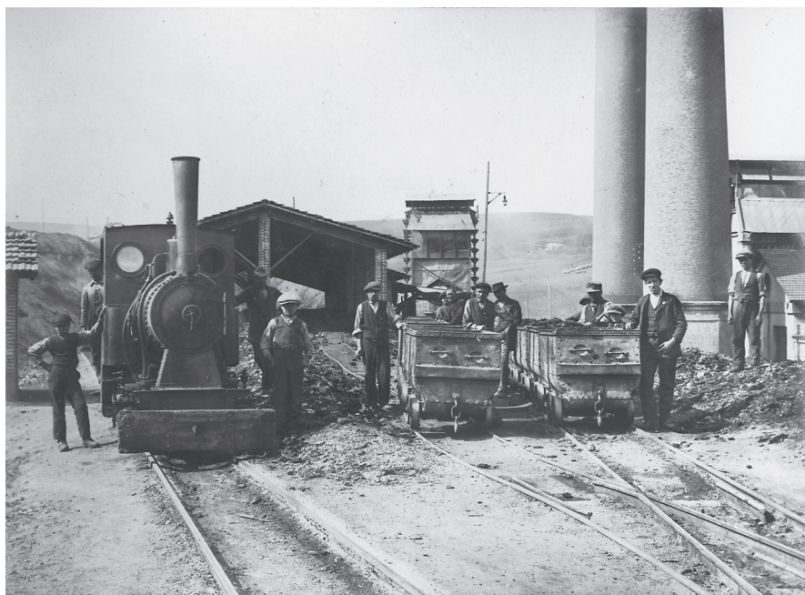
Stazione di arrivo alla Centrale Elettrica.
